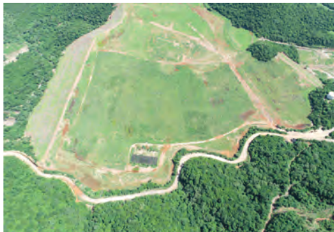
Vista aérea de un depósito de jales secos después de los trabajos de restauración.
