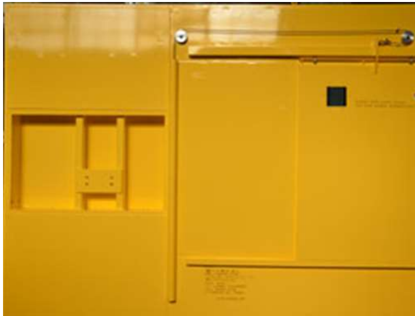
Reguladores para control del flujo de ventilación
